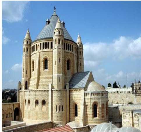
Abbazia della Dormizione di Maria sul monte Sion
